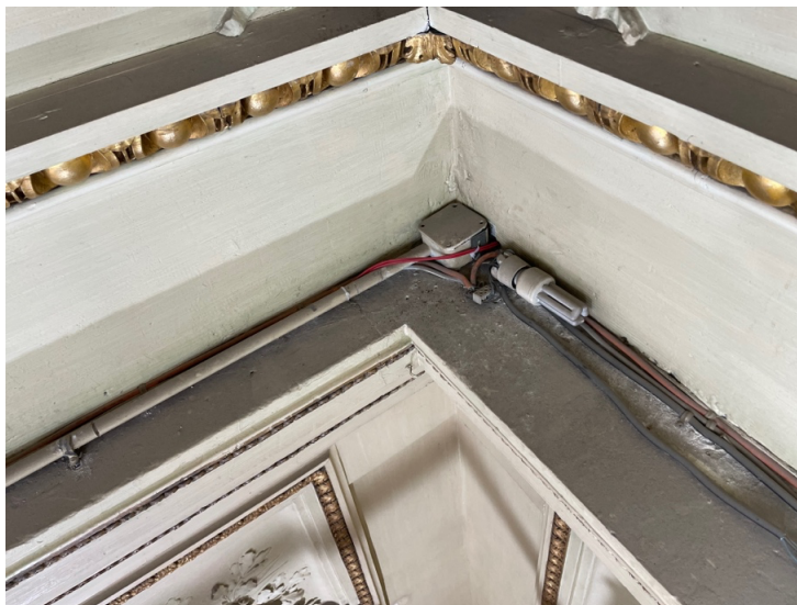
Photo luminaire éclairage de sécurité
