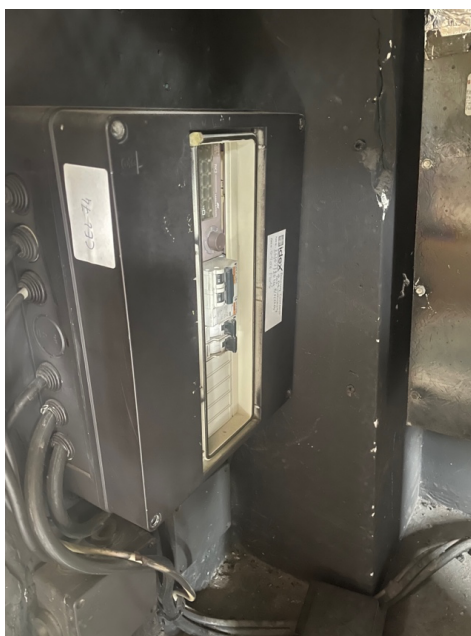
Photo coffret électrique installé dans la cheminée
