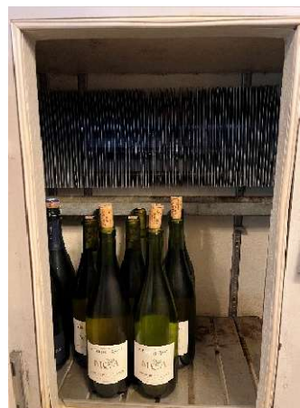
Frigo bar composé d'un évaporateur
