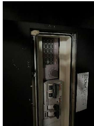
Régulateur de chauffage Marque : LANDIS & STAЕFA Modèle : RK2
